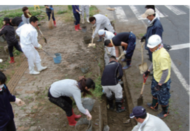
側溝泥だし作業
